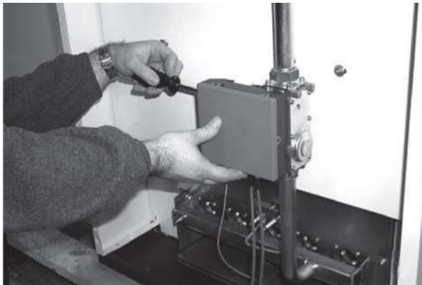
شکل ۸- باز کردن پیچ های جعبه کنترل
