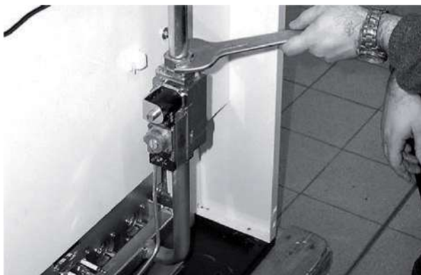
شکل ۱۰- باز کردن مهره نگهدارنده لوله گاز ورودی به شیر گاز
